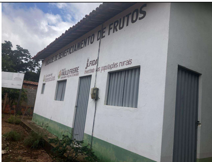
Figura 03 - Vista externa da Unidade de Beneficiamento de Frutos na Comunidade Zabelê, município de Nova Olinda, ainda sem funcionamento.
